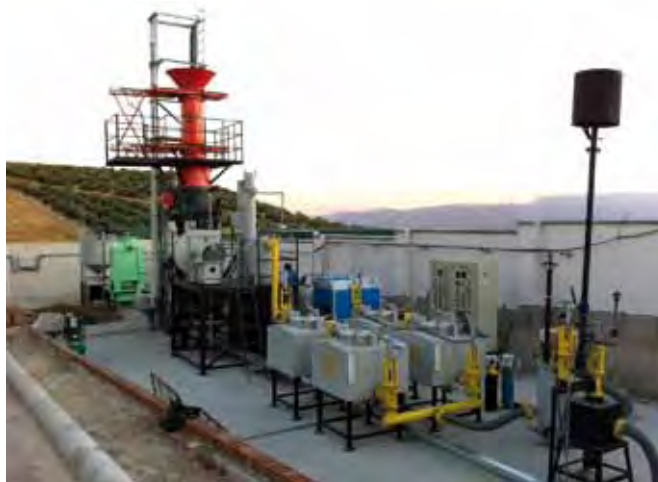
Il sistema di gassificazione della biomassa installato come prototipo durante RESOLVE presso la sede del partner UNIOLIVA (Ankur GAS-70).
