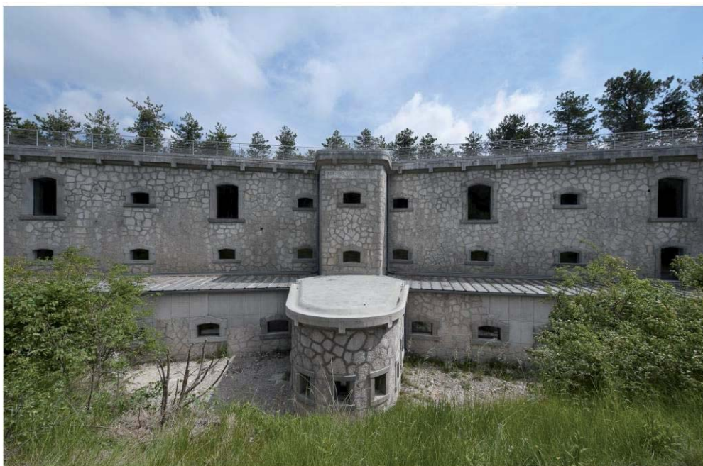
Forte Santa Viola, dopo l'intervento di restauro.
