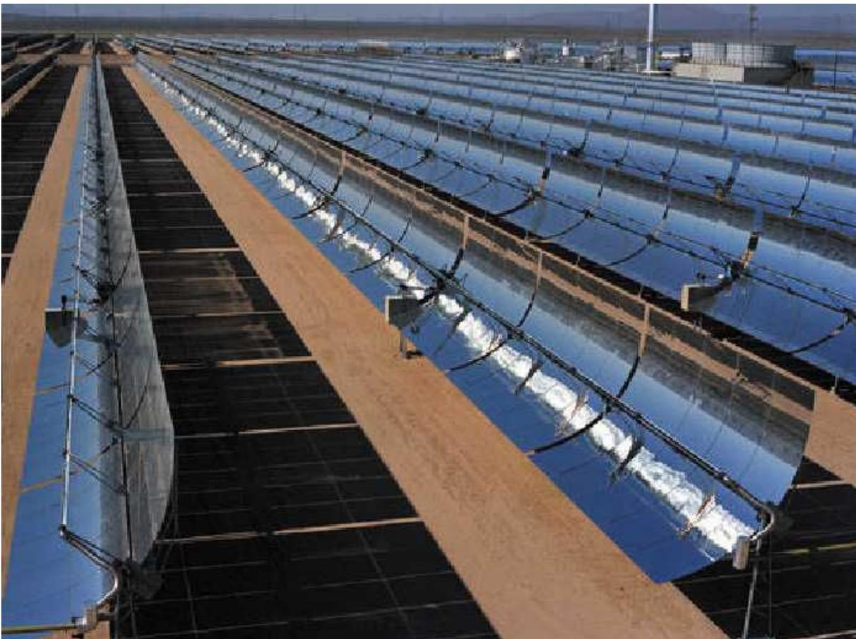
*Fig. 24 – Collettori parabolici lineari*
