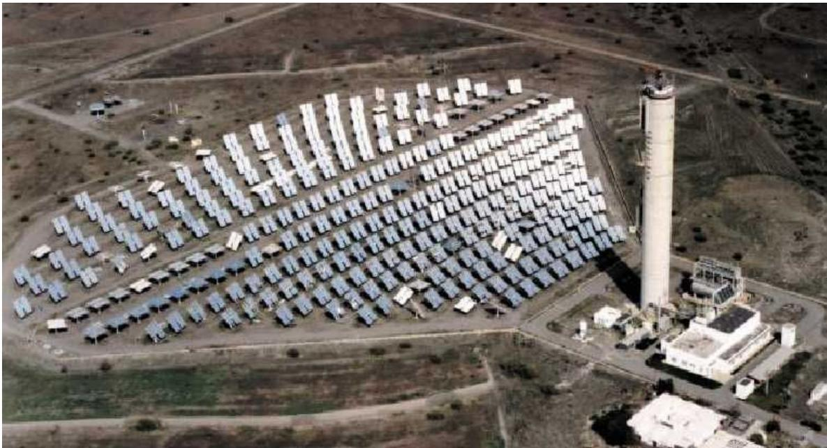
Fig. 22 – Campo eliostati di impianto a torre
