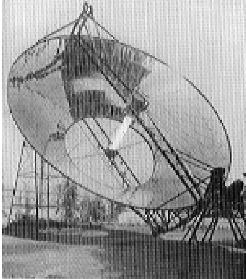
Fig. 20 – Collettore a disco troncoconico di Eneas (1903)
